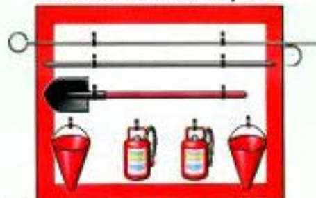
**ПРЕДНАЗНАЧЕН** для размещения первичных средств пожаротушения, механизированного инструмента и пожарного инвентаря
